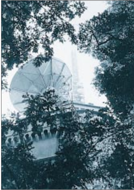
Die QSL von Radio Vatikan zeigt zwei Erdfunkstellen und die UKW-Sendeantenne auf dem Vatikanberg.
